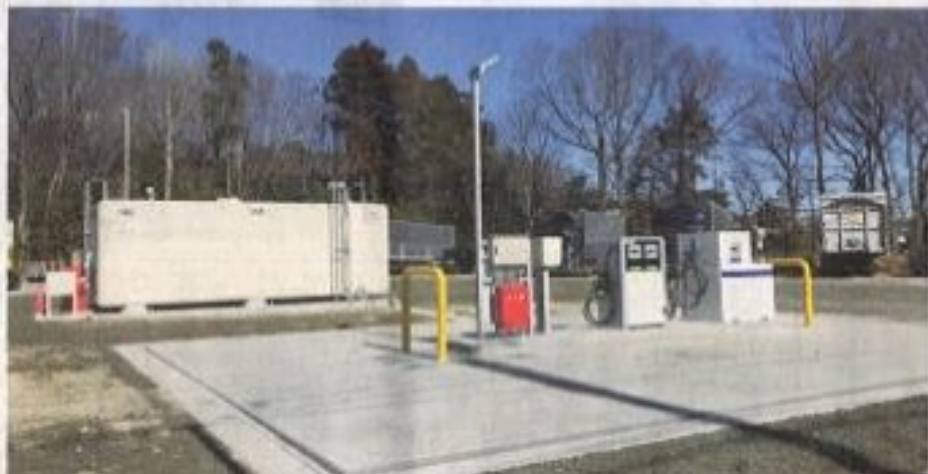
コンボルトタンクを設置した自家給油所
